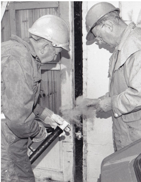
Rottebekæmpelse. To rottefængere i færd med at finde rottehuller ved at sende røg ind i rørrerne. Foto: Bent Kjeldsen.
